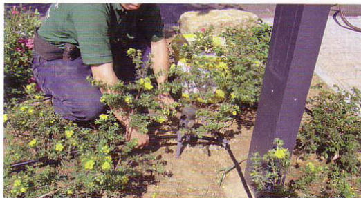
Problemlos zu fixieren: Rohrhälter werden mittels Gummihammer in den Boden geschlagen – sie halten die Rohre an der Bodenoberfläche.
