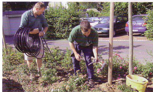
Einfach zu handhaben: Zu zweit werden die Tropfrohre ausgebracht. Ein Mitarbeiter führt das flexible Rohr, der andere fixiert es am Boden.
