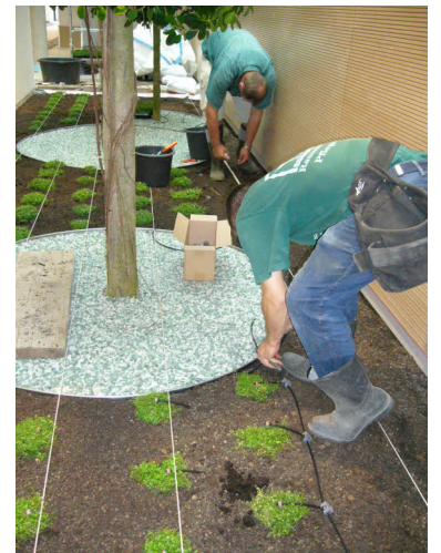
Montage Einzeltropfer 2 l/h für Bodendecker
