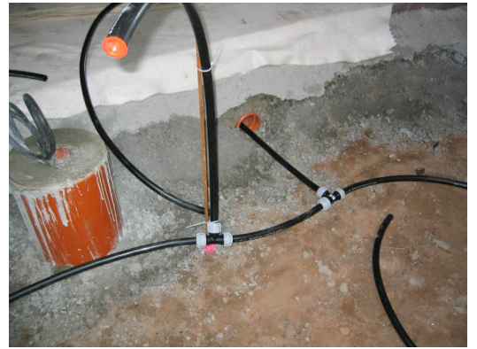
Vormontage der Hauptleitungen und Verteilung in den einzelnen Parzellen
