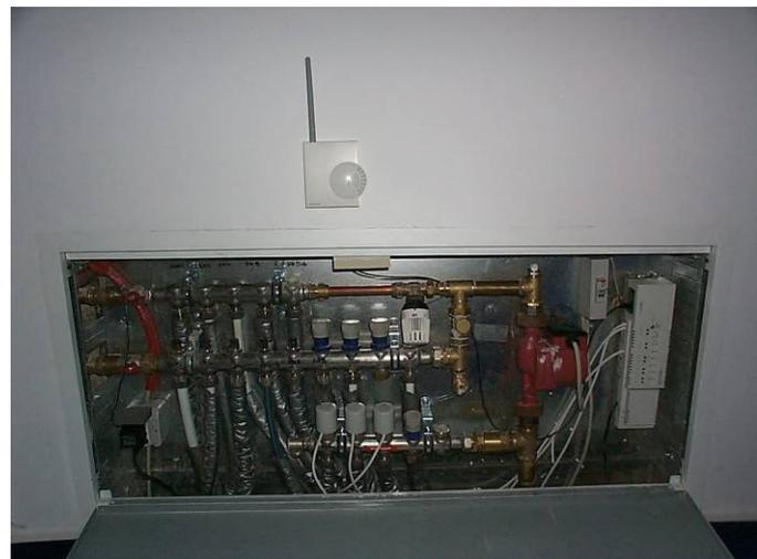
Lüftung-, Schattierungs- und Heizungsregelung erfolgen über zwei mit Mikrochips gesteuerte Anlagen. (Klimacomputer + Hometronic)
