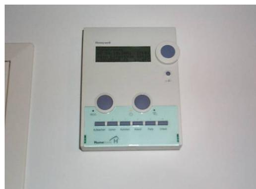
Die vorgegebenen Sollwerte werden fortlaufend von Sensoren überprüft. Wichtige Parameter für das Wohlfühlklima sind: Innentemperatur, Außentemperatur, Luftfeuchtigkeit, Lichtstärke (Lux), Windgeschwindigkeit, Regenmesser
